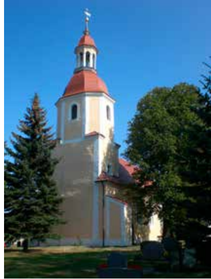
Der wiedererrichtete Schönaer Kirchturm
